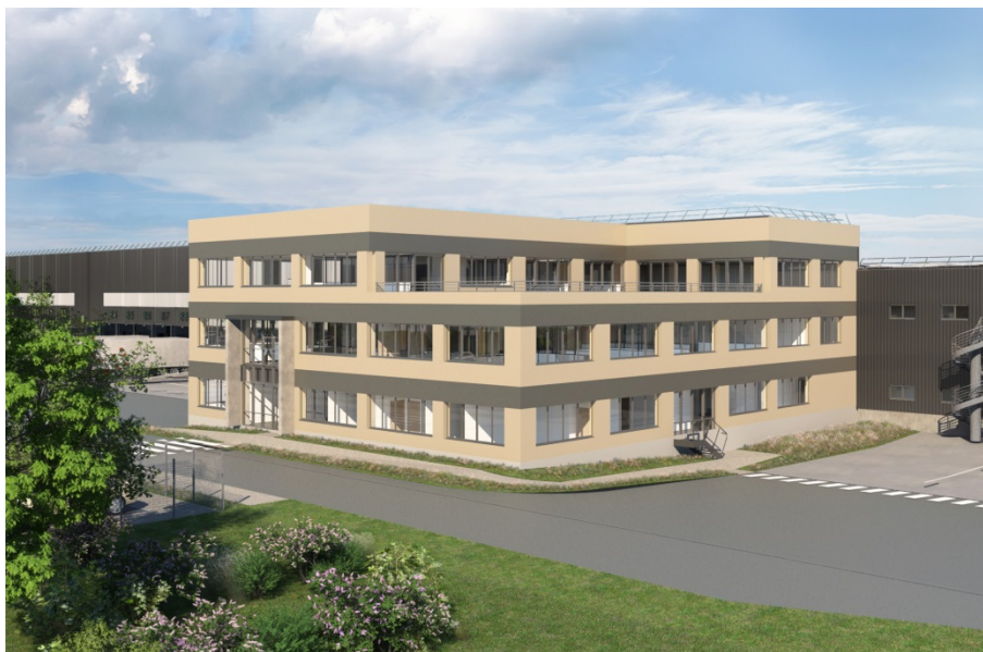
Figure 19 : vue du bloc bureaux locaux sociaux
